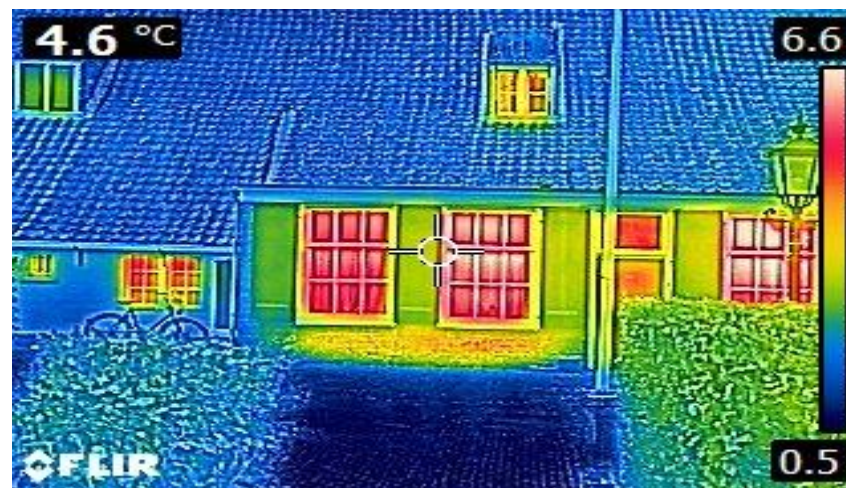
Figuur 15: Warmtebeeld van een woning met geïsoleerd dak en ongeïsoleerde ramen en gevel
